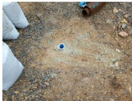
Disquage du tubage au ras du sol
