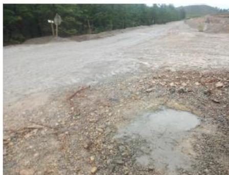
Vue du site après les travaux de rebouchage de Pz1-4
