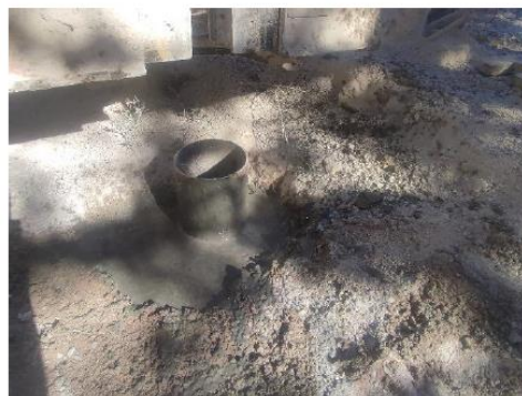
Cimentation du prétubage
