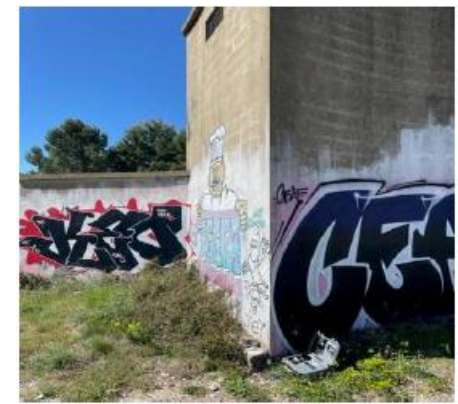
Château d'eau de Montaud
